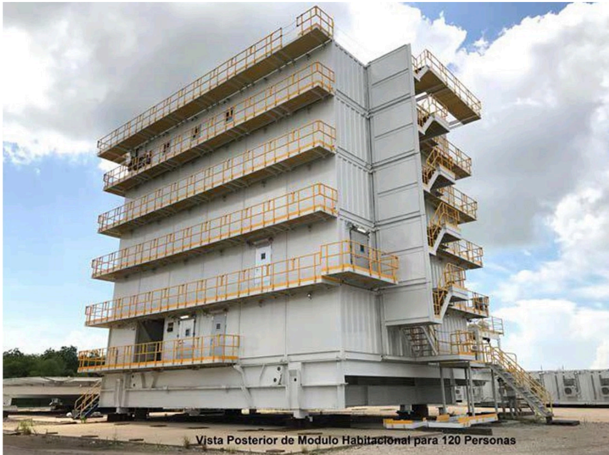
EDIFICIO HABITACIONAL PARA 120 PERSONAS, VISTA QUE DA AL FRENTE DE AGUA. (2-PESCANTES PARA BOTES SALVAVIDAS)
